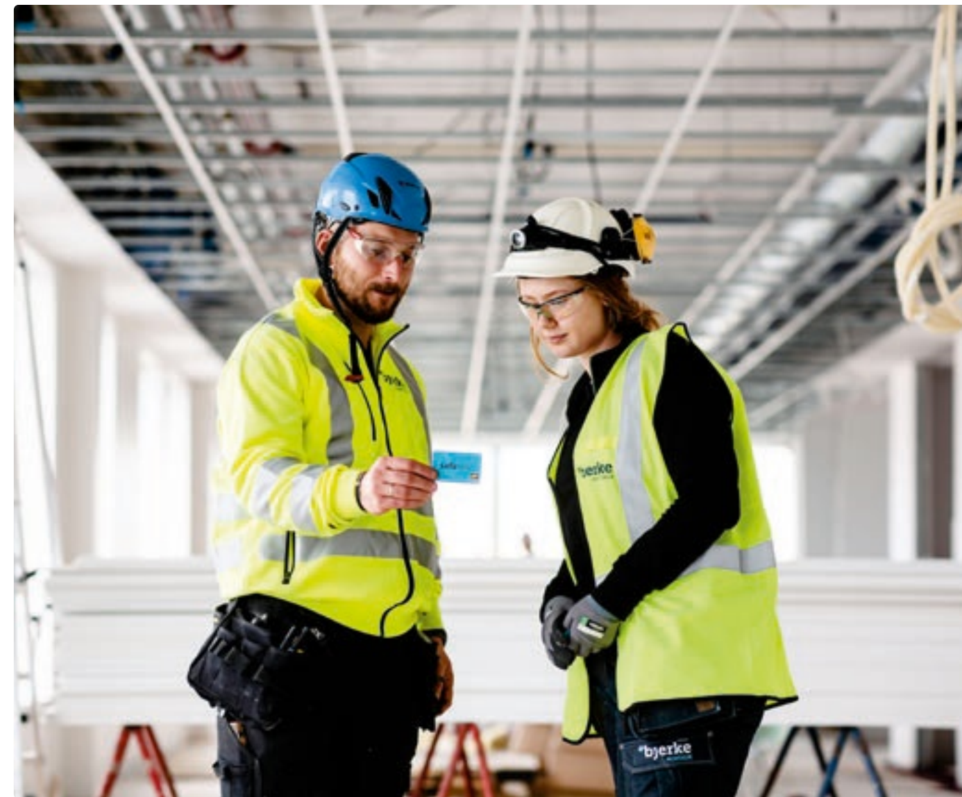
» Montasjeleder Kristian Ness Billing og HMS-ansvarlig Moa Stordahl fra Bjerke Montasje bruker Safetalk aktivt i forbindelse med risikofylt arbeid. Som her i heissjakten i et nytt kontorbygg på Lambertseter.
