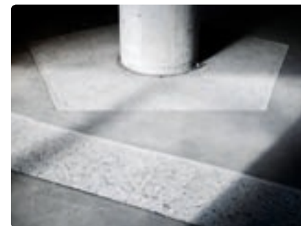
» Universell utforming er markert med betongfres. Hver søyle er omringet av en femtakket stjerne for å hindre at folk går inn i dem.
