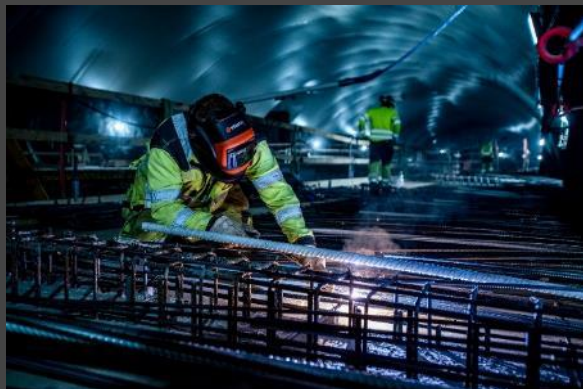
Vannbehandlingsanlegg, Huseby Kunde: Oslo kommune/VAV
