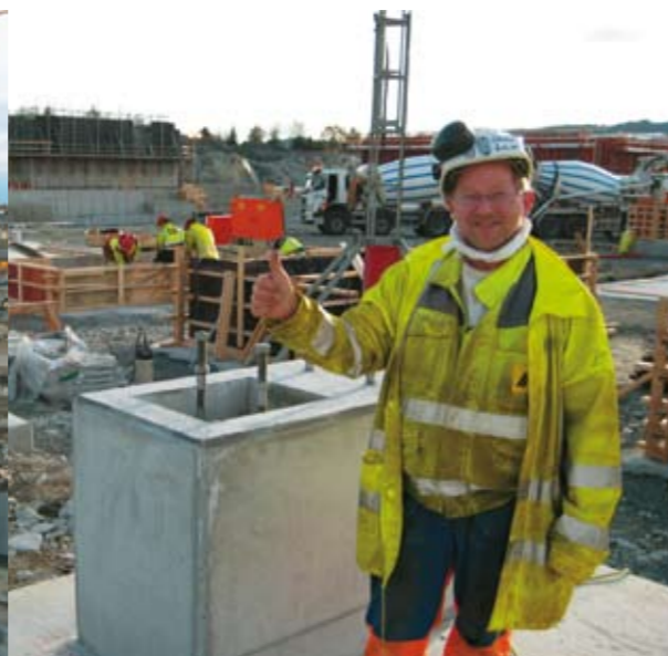
Gøran Åhlin er betongbas for det ene skiftet på Mongstad
