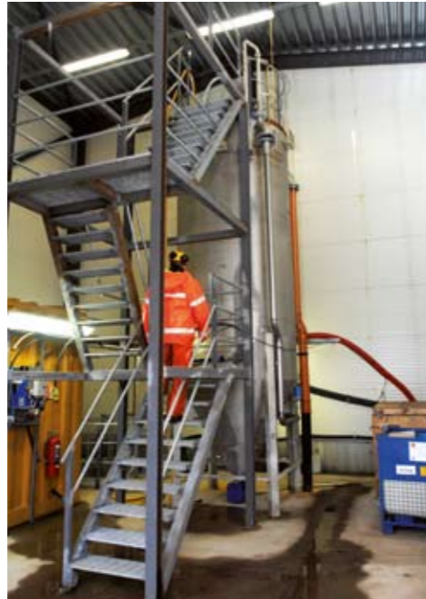
Vannet fra spyleprosessen går gjennom et fellingsanlegg før det filteres gjennom et selvrensende sandfilter, kontrolleres og slippes ut i fjorden.
