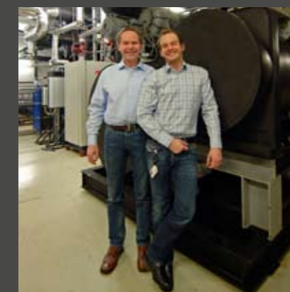
– Flere velger energisentraler, forteller Tor Olsen og Andreas Jul Røsjo i AF Energi & Miljøteknikk.
